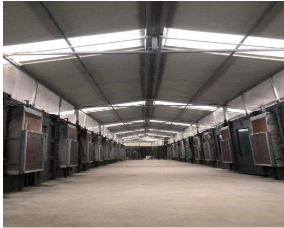
图 5 封闭式模块化智能化方舱猪舍内部
